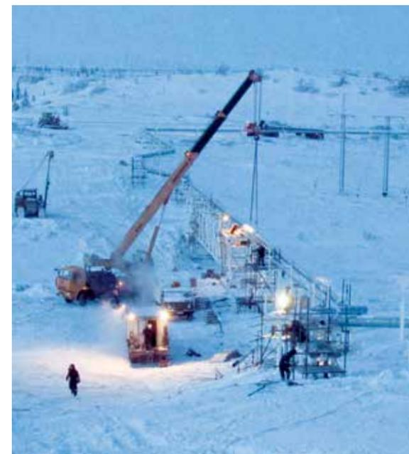
Строительство балочного перехода нефтепровода
