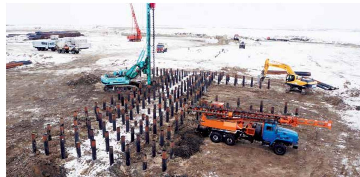
Забивка свай под строительство резервуара на Сузунском месторождении
