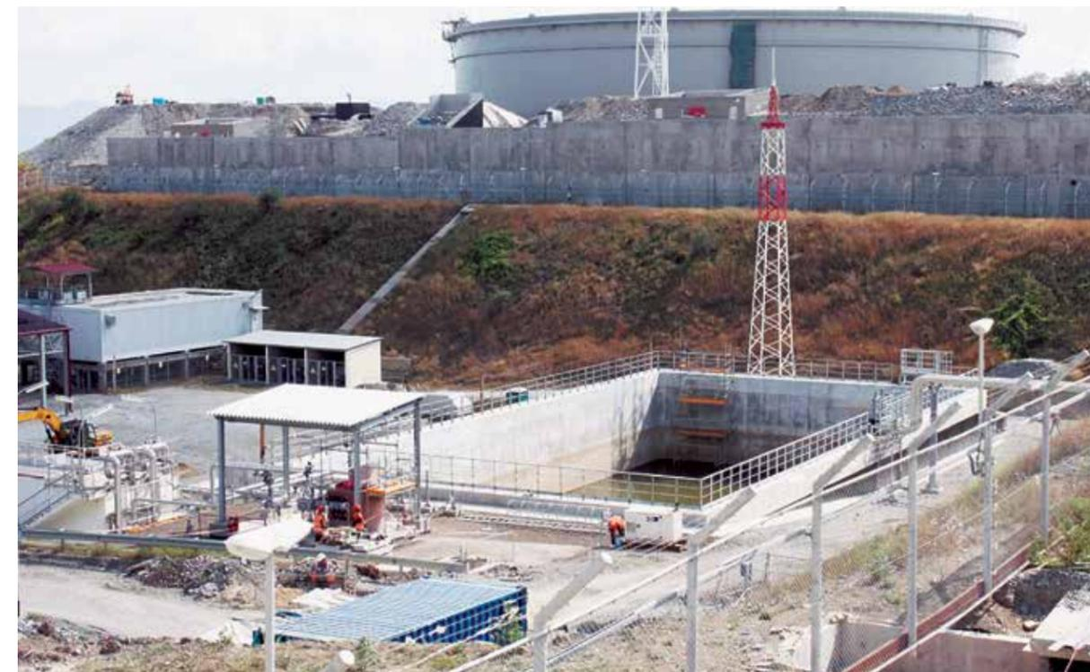
Аккумулирующий пруд №1 дождевых стоков на Резервуарном парке Морского терминала Каспийского трубопроводного консорциума
